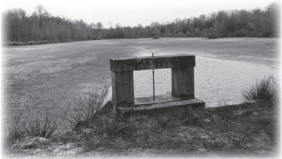
Figure 3. Étang de Dombes après vidange complète.
