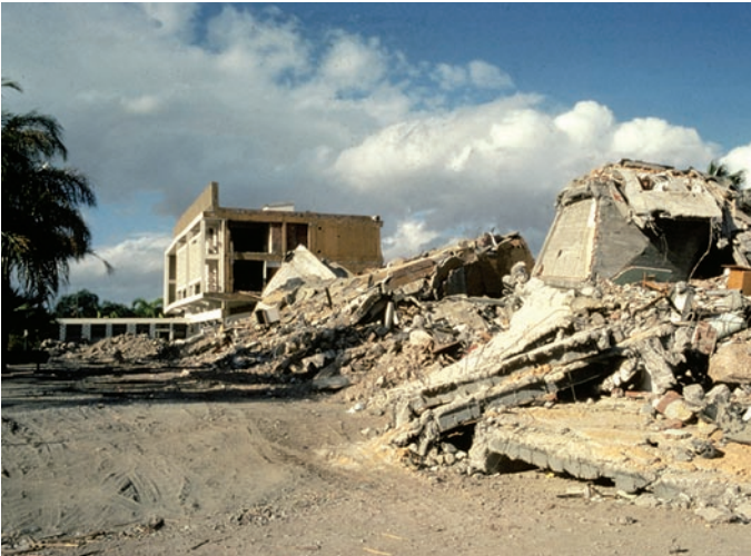
Le séisme de magnitude 7.3 qui a touché El Asnam (Algérie) le 10 octobre 1980 a été suivi d'une réplique de magnitude 6.3 qui a achevé de détruire la ville
