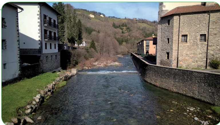
Figure 1. Protection d'habitations contre les inondations, grâce à une digue (rive droite) et un enrochement surmonté d'une couverture végétale (rive gauche).
